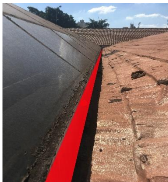
Figura 5 Calha Longitudinal (detalhe)
